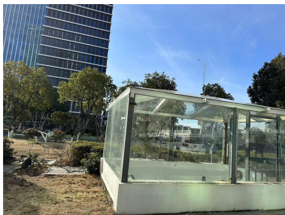
图 3-2 中丹园一期污水处理站
